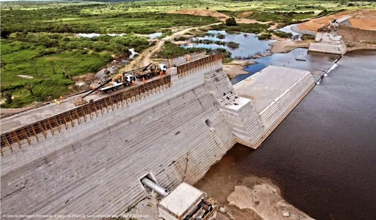
A obra da Barragem Fronteiras, a cargo do DNOCS, se encontra parada - Foto: Reprodução
